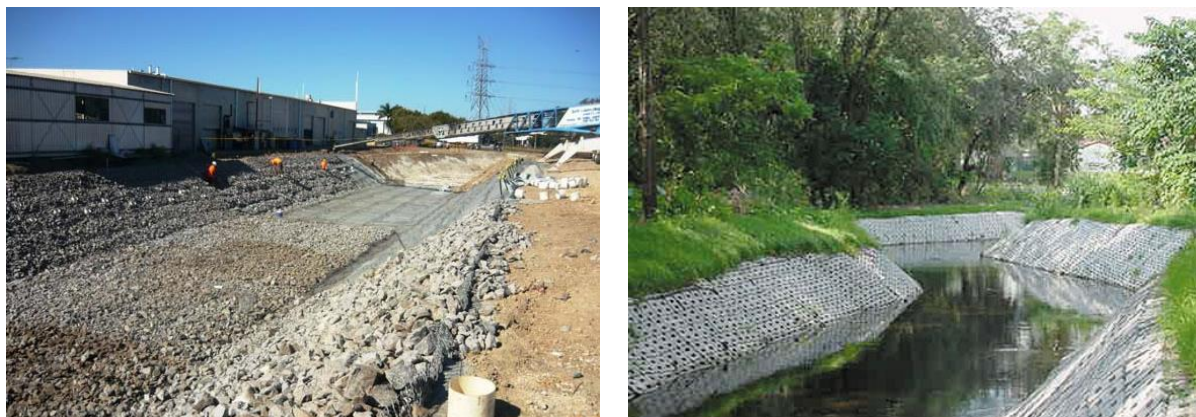
Fotografia 3: Revestimento de linhas de água com colchão reno
