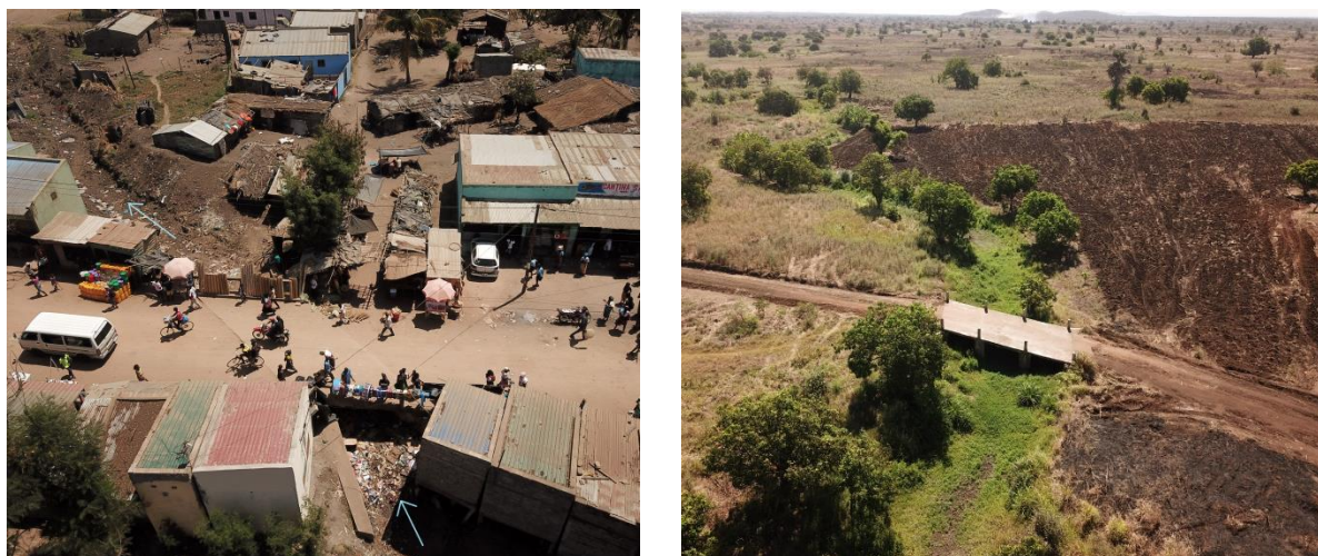
Fotografia 2: Obstrução parcial por construções, vegetação e deposição de lixo em passagens hidráulicas (pontecas) sobre valas de drenagem
