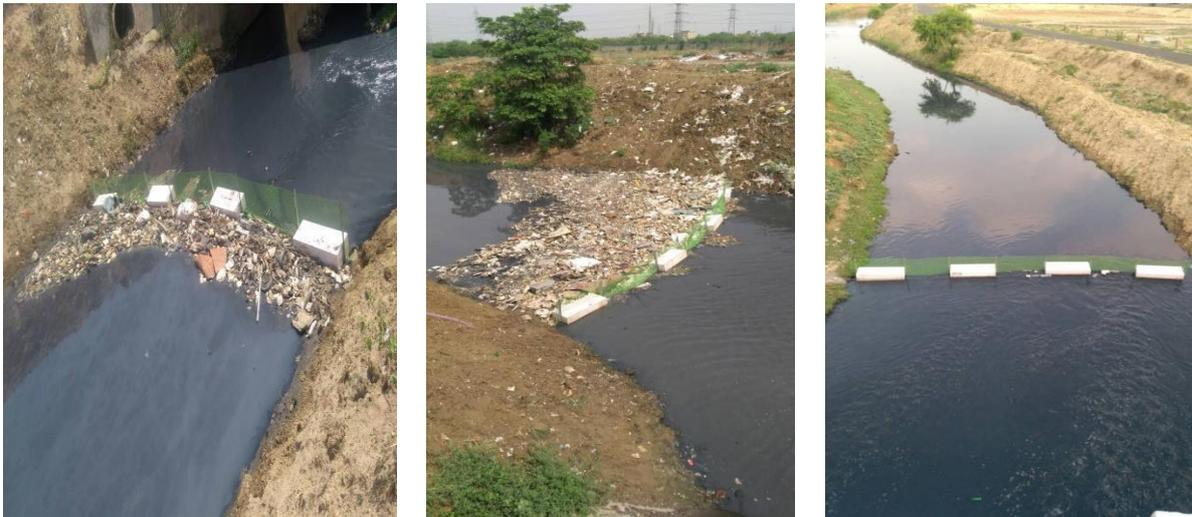
**Fotografia 8:** Estrutura para retenção de resíduos sólidos em canais
