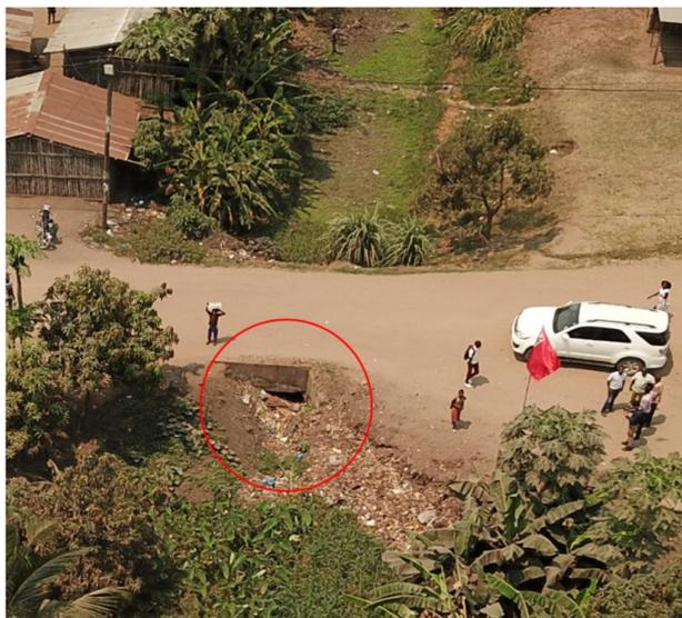
**Fotografia 6:** Obstrução parcial por vegetação, deposição de lixo em valas e passagens hidráulicas (pontecas) e por construções
