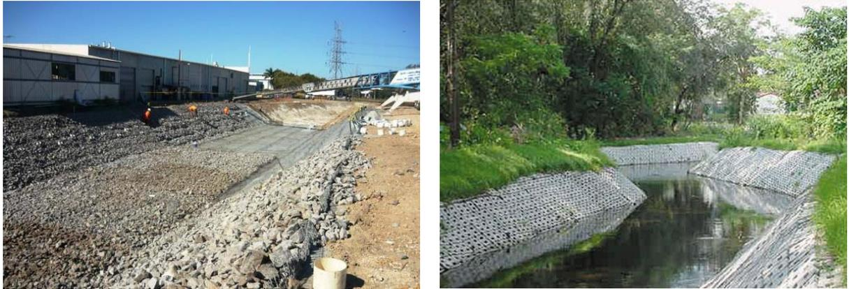
**Fotografia 7:** Revestimento de linhas de água com colchão reno
