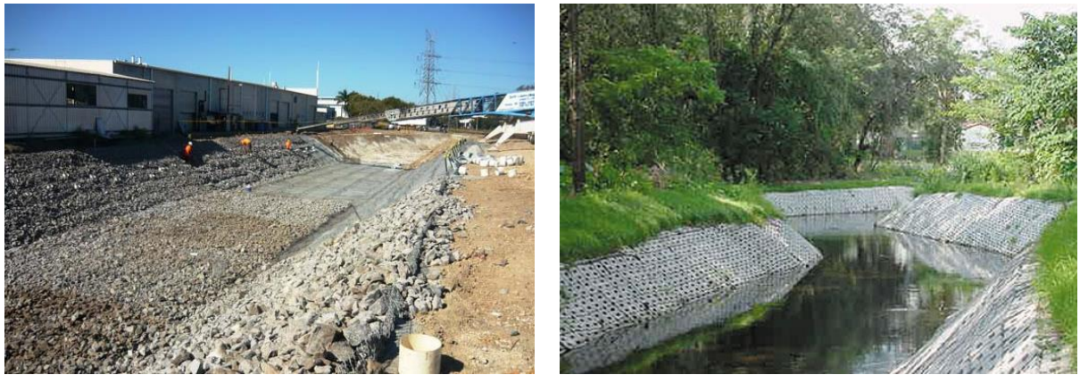
Fotografia 1: Revestimento de linhas de água com colchão reno
