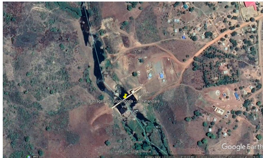
Figura 22: Barragem da Gorongosa
