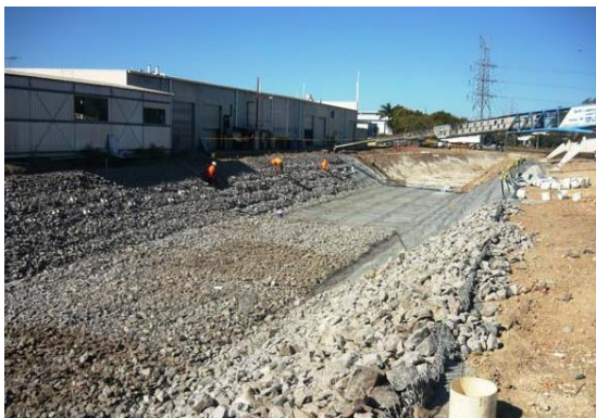
Fotografia 4: Exemplo do Revestimento de linhas de água com colchão reno
