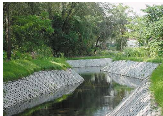
Fotografia 4: Exemplo do Revestimento de linhas de água com colchão reno
