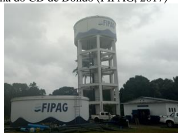
Reservatório apoiado de 250 m 3 , Torre de pressão de 20m de altura e 250m 3 e casa das Bombas
