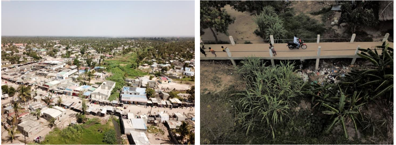
Fotografia 3: Obstrução da Linha de Água
