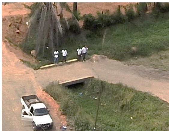
Fotografia 2: Obstrução parcial por vegetação e deposição de lixo em passagens hidráulicas (pontecas) sobre valas de drenagem
