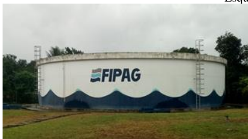
Reservatório apoiado de 2500m 3
