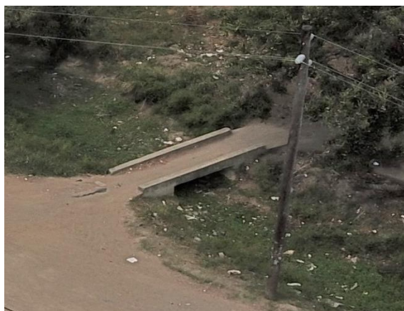
Fotografia 2: Obstrução parcial por vegetação e deposição de lixo em passagens hidráulicas (pontecas) sobre valas de drenagem
