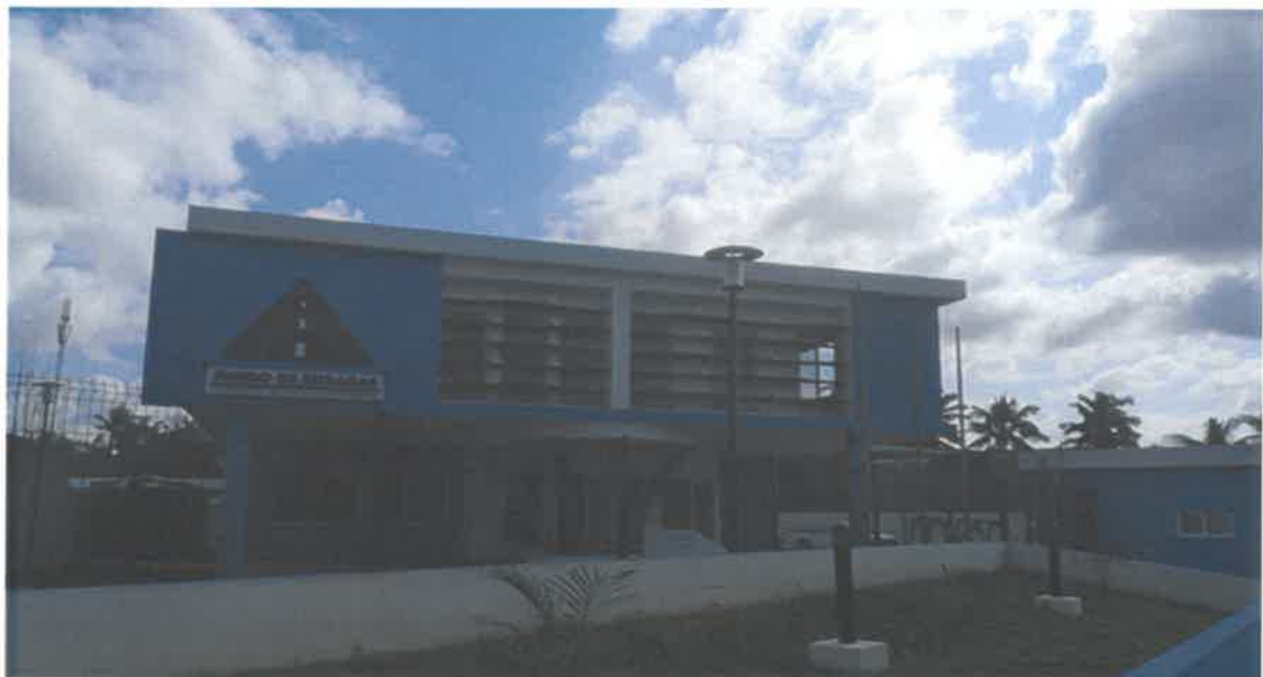
Construção do Edifício da Delegação do Fundo Provincial de Estradas de Inhambane - 2019
