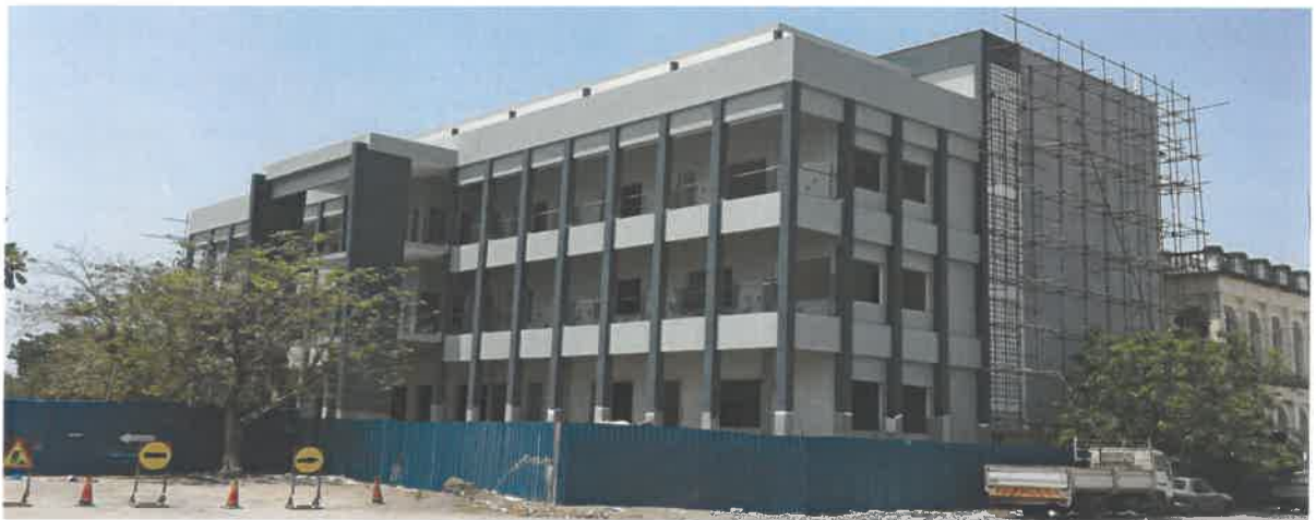
Construção do Edifício do Tribunal Judicial da Província de Sofala
