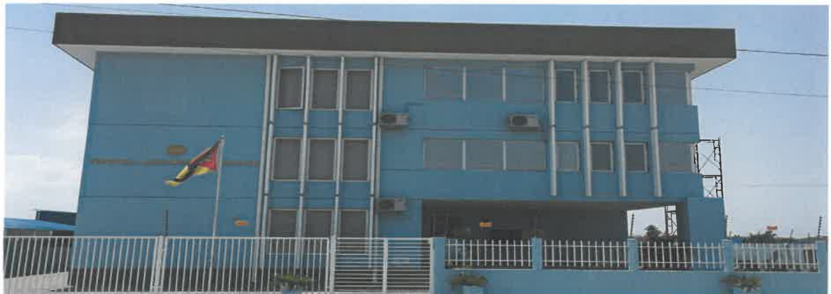
Construção do Edifício do Tribunal Aduaneiro da Província de Sofala
