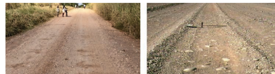
Figura 4-35: Perda de agregado
