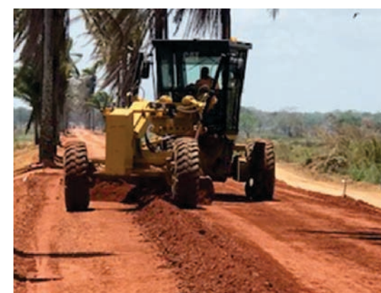
Figura 4-56: Operação de espalhamento com motoniveladora articulada
