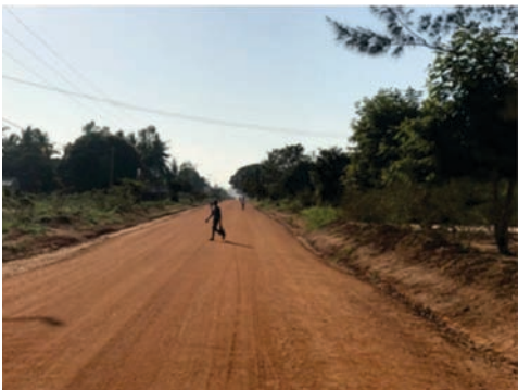
Figura 4-25: Estrada com drenagem lateral aceitável
