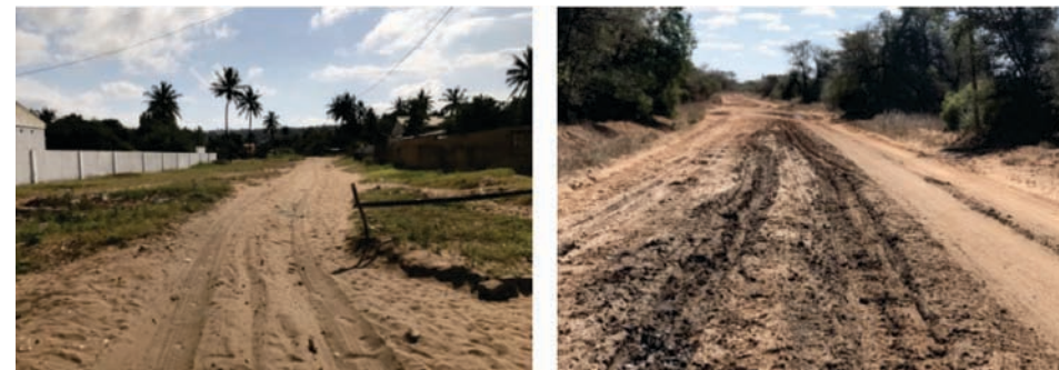
Figura 4-30: Rodeiras em estradas não revestidas
