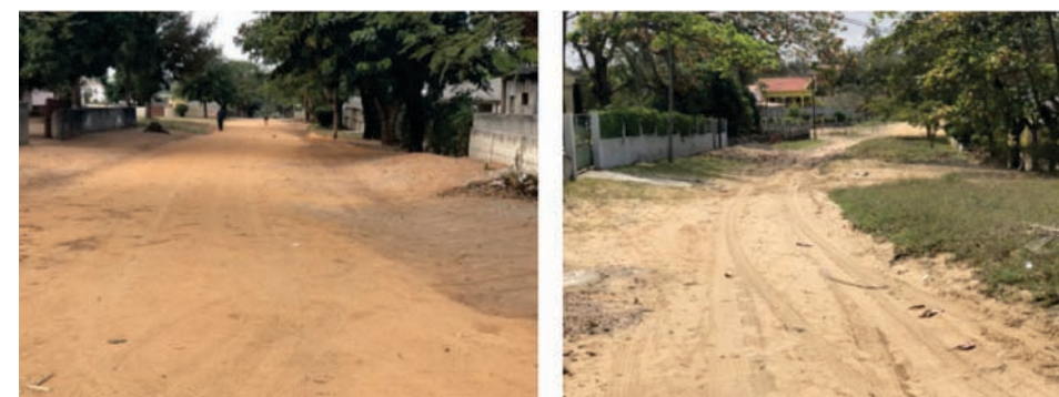
Figura 4-24: Secção transversal adequada (esq.) e imprópria (dto.)
