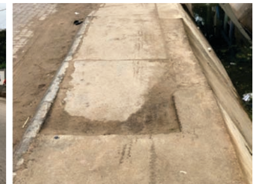
Figura 5-3: Consequência do estacionamento indevido
