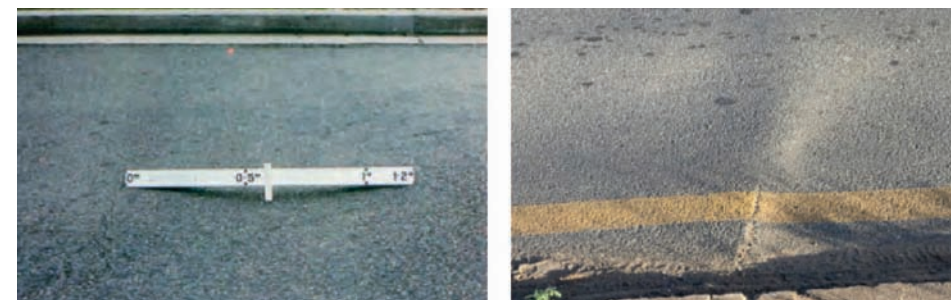
Figura 4-17: Deformações / elevações
