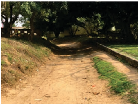
Figura 4-28: Estrada que se transforma em canal durante a chuva
