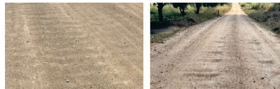
Figura 4-33: Ondulações em estradas não revestidas
