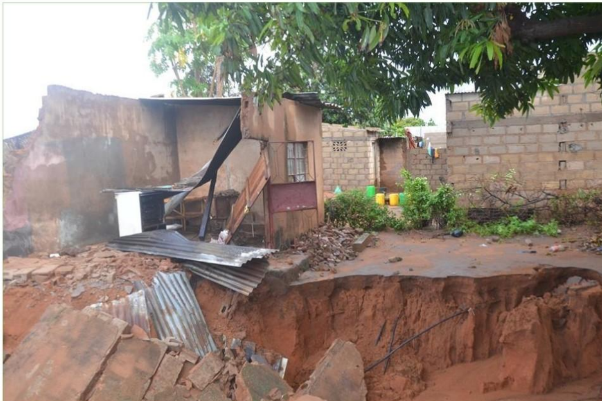
Figura 2. Desabamento de casas construídas em áreas de risco perto da Avenida Julius Nyerere águas devido a erosão provocada pela chuva
