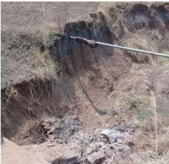
Figura 35 - Tubagem de água à vista devido à erosão
