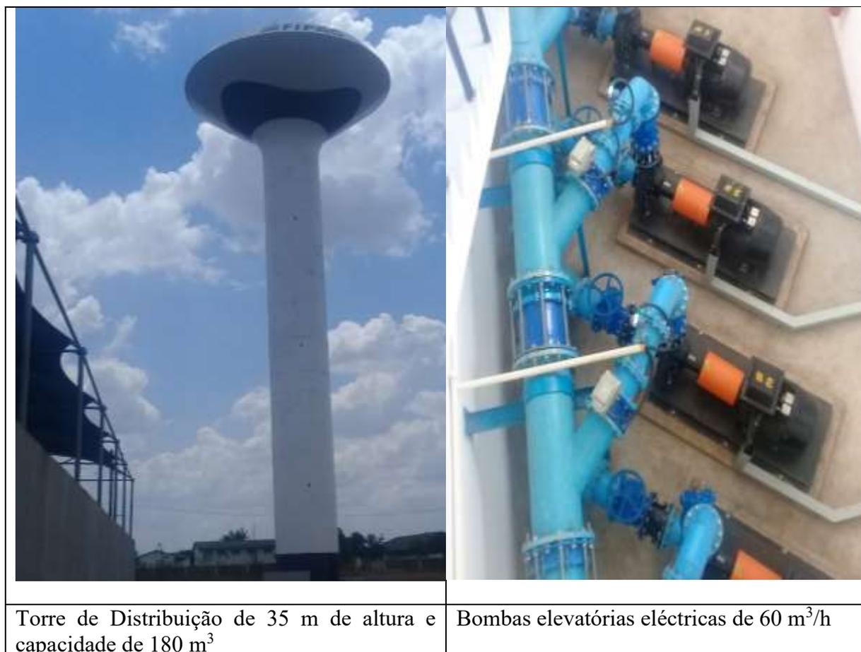
Figura 24 - Torre de pressão e Estação de bombagem correspondente do SAA de Cuamba
