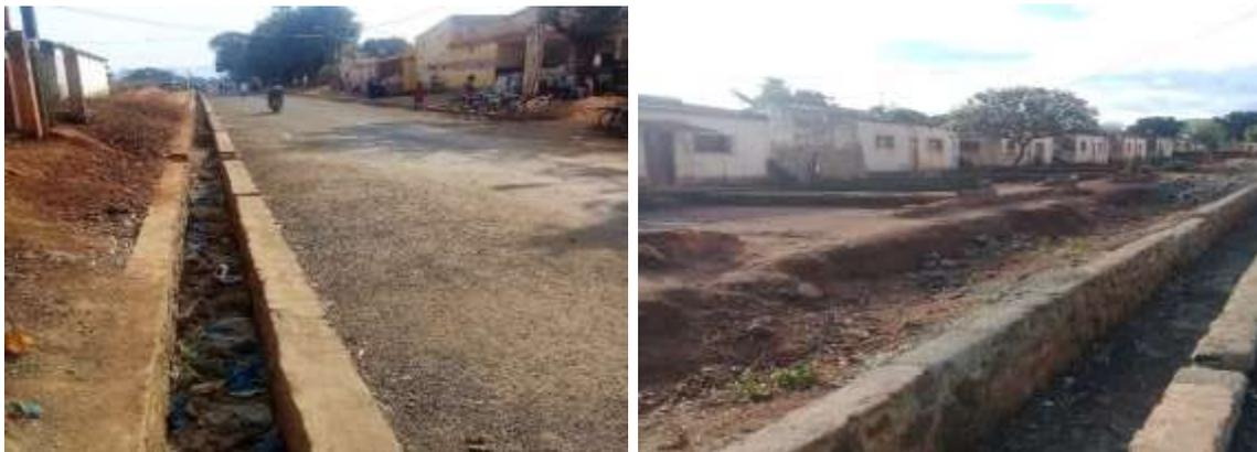
Figura 24 Vala de drenagem com deposição de lixo (à esquerda) e Vala de drenagem em zona de erosão (à direita)
