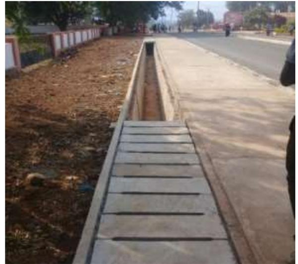
Figura 25 Valas de drenagem de águas pluviais em construção. Tubagem em betão e caixa de ligação à vala (à esquerda) e Vala em betão com protecção superior (à direita)
