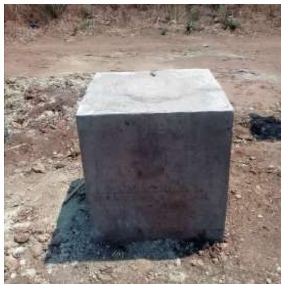
Figura 20 Furo experimental executado para fonte de água do SAA com caixa de protecção
