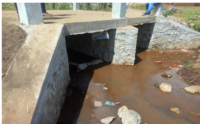
Figura 53: Projecto PRODEM – Pormenor de um aqueduto construído no âmbito do projecto na rua Quatro Estradas/Cruz N103
