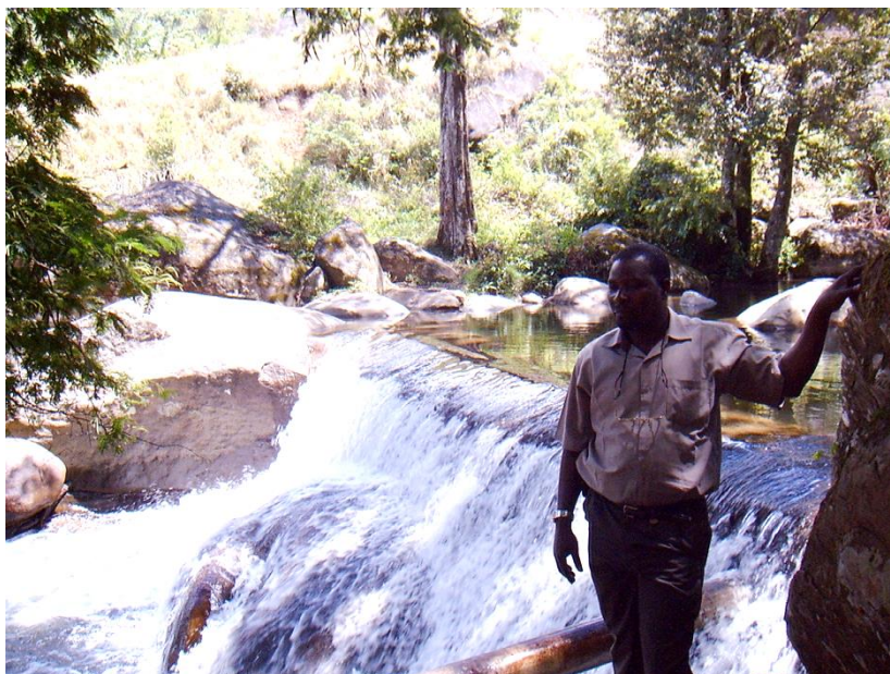
Figura 74: Fonte de captação de água sobre o Rio Licungo do sistema público de Abastecimento de Água ao Gurúé
