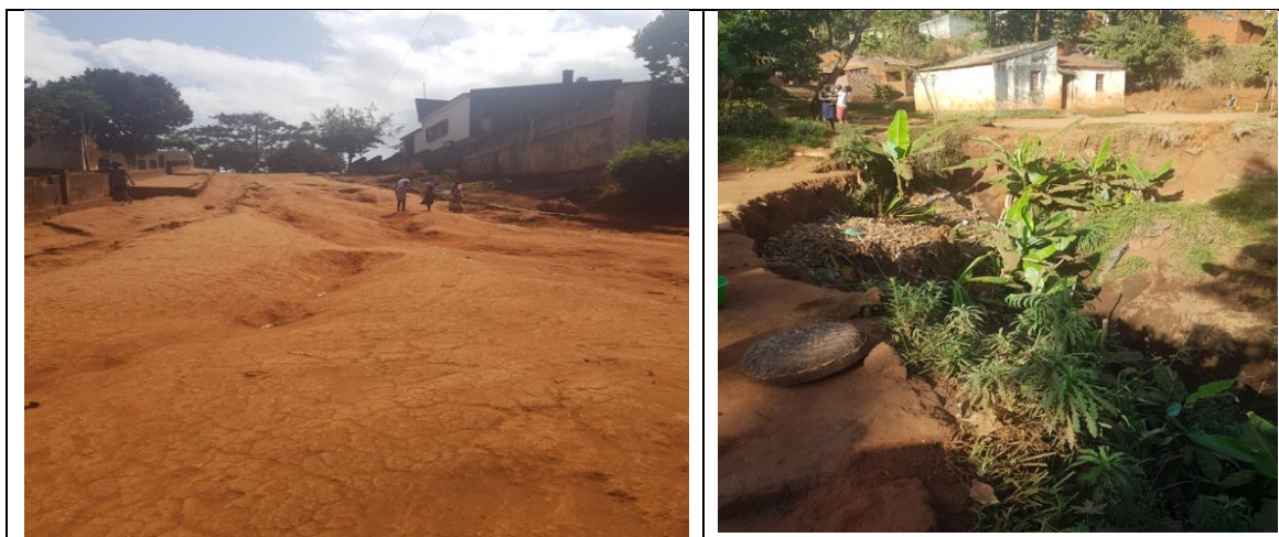
Figura 47: Áreas em risco por erosão
