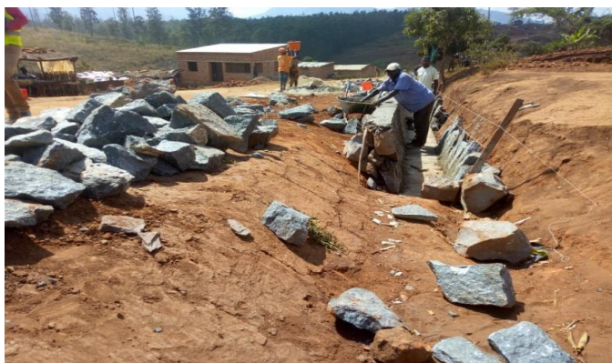
Figura 52: Projecto PRODEM - Construção de valetas revestidas em pedra argamassada na rua Quatro Estradas/Cruz N103
