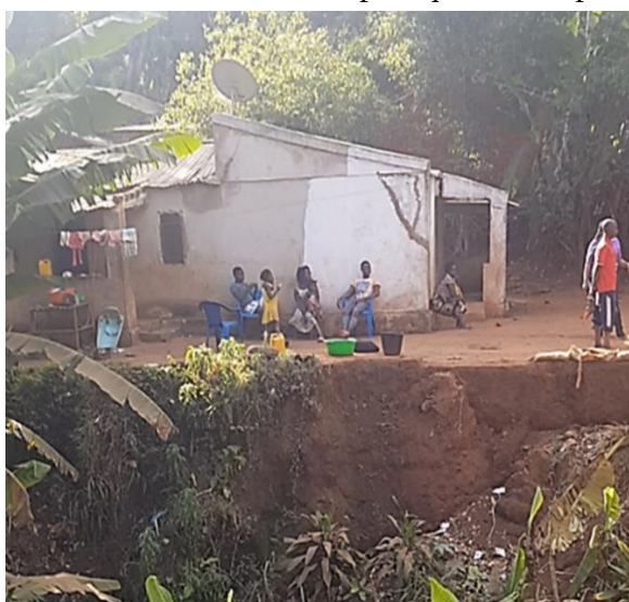
Figura 44: Zona de erosão devido à falta de drenagem de águas pluviais no Bairro 1º de Maio,
