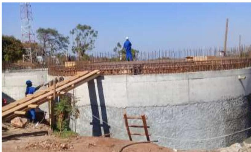
Figura 34 Novo SAA em construção: depósito de 250 m<sup>3</sup>
