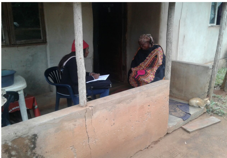
Figura 4-1: Uma casa precária de paredes de bloco/cimento (arredores de Xai-Xai)
